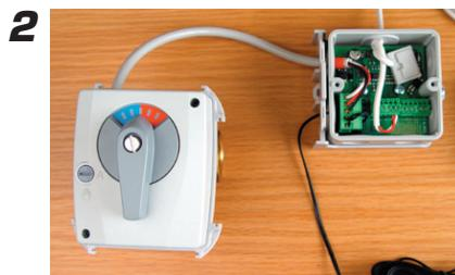
Montera plattan (blå/röd) för shuntens lägesindikering på motorn och sätt fast vred enligt bild 3. **OBS** Motorn levereras alltid i mittposition och ratten passar endast i det läge motorn står i. Sätt i och dra fast skruven i centrum på motorn.
